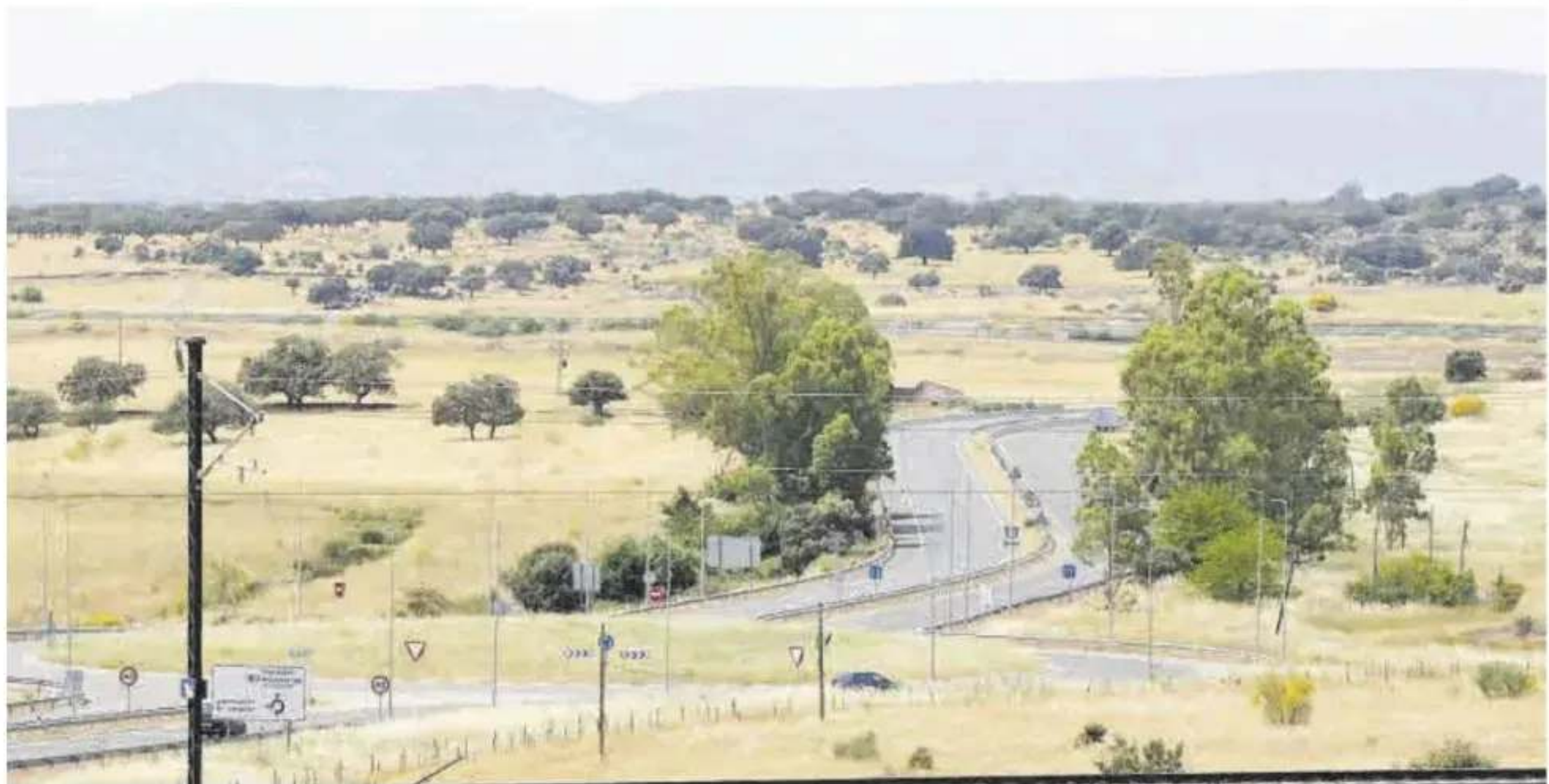
Desdoble de la carretera a Malpartida, a la altura de la rotonda de El Junquillo.
